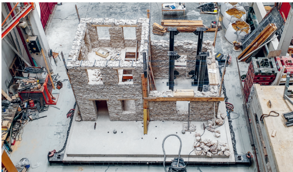
Maison en pierre de la vieille ville, reconstruite à l'échelle 1:2 pour un test de séisme. Photo: I. Tomić/EPFL
