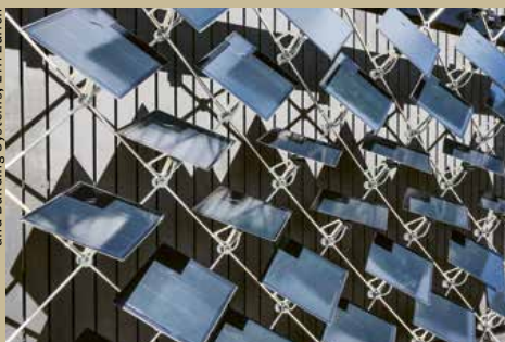
Les éléments photovoltaïques mobiles suivent le soleil comme des tournesols.
