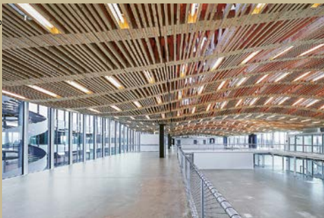
Exemple de construction numérique et robotisée: le toit du Arch-Tec-Lab à l'ETH Zurich.
